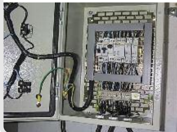
Photo 16 : Armoire électrique - recherche horloge
